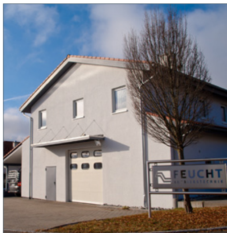
Firmengebäude Feucht Antriebstechnik
